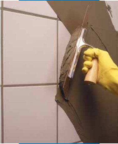
Rasatura di rivestimento esistente con Planipatch
